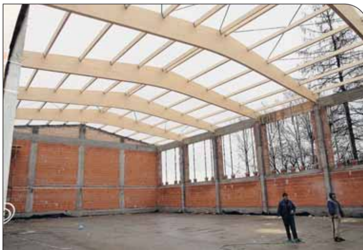
Budowa sali gimnastycznej SP w Józefowie
